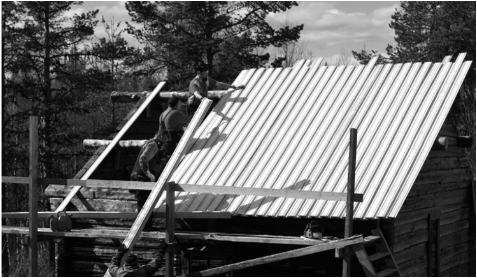
Ensimmäinen uusi kattolape nakuteltiin paikoilleen ripeään tahtiin.
