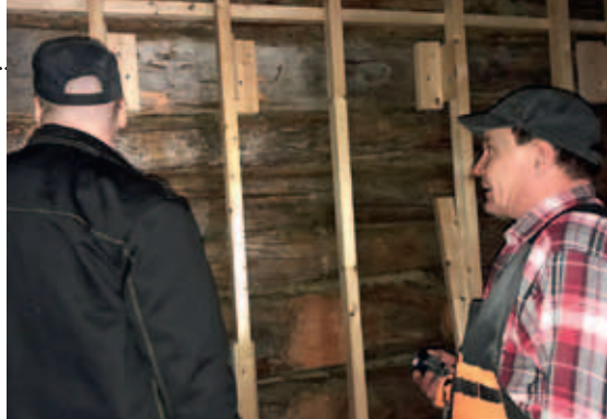
Härkäselässä työ etenee monella rintamalla. Esimerkiksi sisäseinien koolaukset ovat valmiit kaikissa kerroksissa ja samalla on myös rakennuksen yläkertaan vievien ulkoportaiden askelmat uusittu miltei jokaista lankkua myöten.
