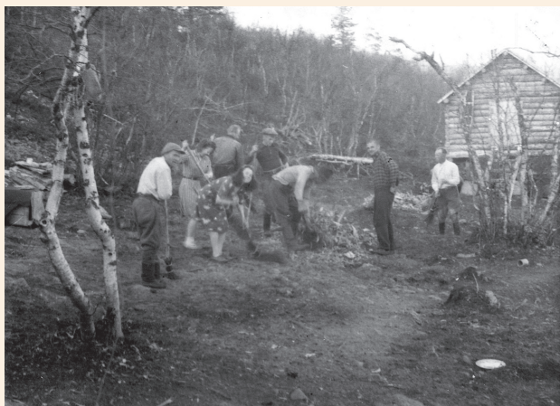
Kun kaivu- ja muilta töiltä jäi aikaa, pidettiin asuinympäristöstä kultamailla huolta. Kuvassa Morgamin porukkaa pihansiistimispuuhissa 1940-50-lukujen taitteessa.
