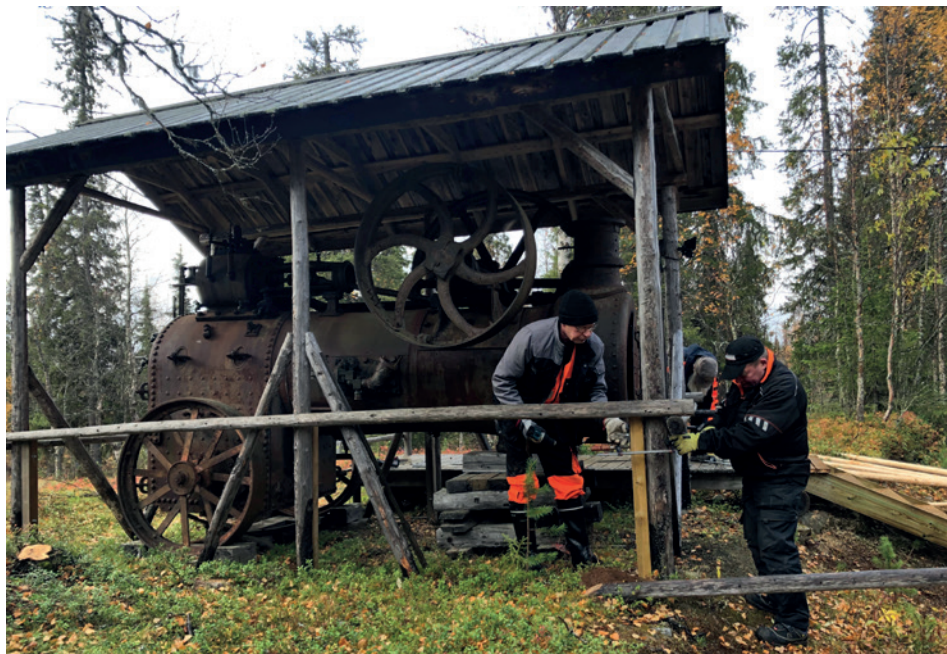
Höyrypannun katos on taas aiempaa ehompi ja kestää jonkin aikaa vuodenaikojen vaihteluja.
